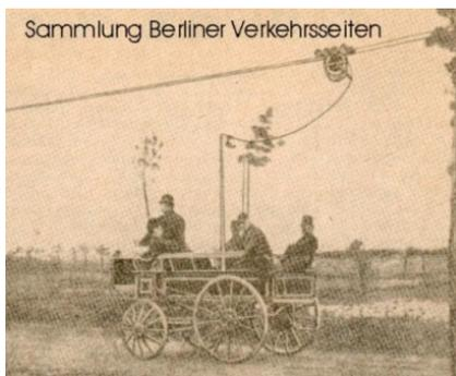
Am 29. April 1882 führte Werner von Siemens in Halensee bei Berlin einen elektrisch angetriebenen Kutschenwagen, Elektromote genannt, auf einer 540 Meter langen Versuchsstrecke vor. Dabei handelte es sich um den ersten Oberleitungsbus der Welt.
