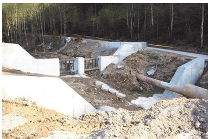
Vor dem Sommer werden noch die Dammschüttung vollendet und zwei Durchlässe zur Querschnittsvergrößerung bei den Brücken eingebaut. Während dieser Arbeiten wird es kurzfristig zu Umleitungen oder wechselseitigen Anhaltungen kommen. Die einzelnen Verkehrseinschränkungen werden entsprechend ausgeschildert und den betroffenen Ortsteilen per Postwurf angekündigt.
